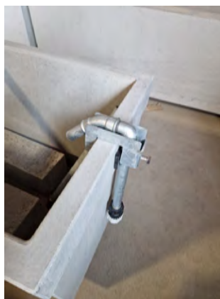
Einlaufrohr Art.-Nr. 4.11 Halterung Art.-Nr. 4.12
